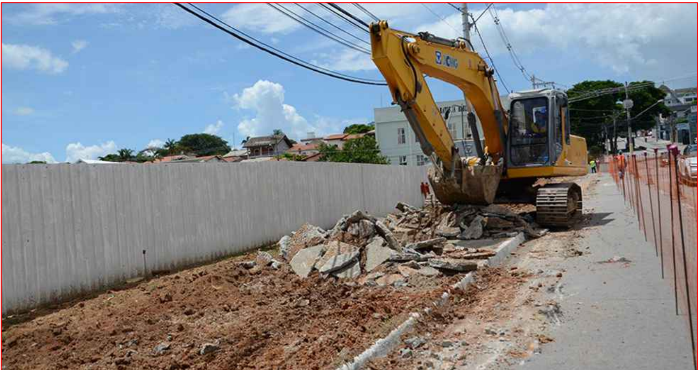
Remoção de Pavimento Intertravado "Paver"
